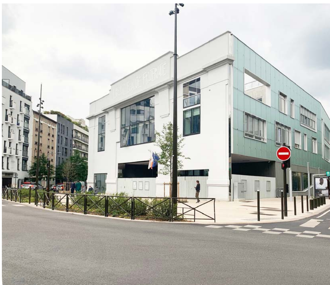
Lycée du Trapèze, Boulogne-Billancourt (92).
